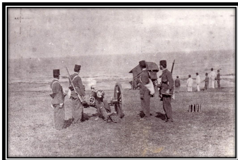
1897 – Pruebas en Punta Carretas con Cañón Canet M 1896 de 75 mm
