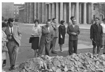
Los berlineses observan el pavimento levantado por los soldados de la RDA en agosto de 1961
