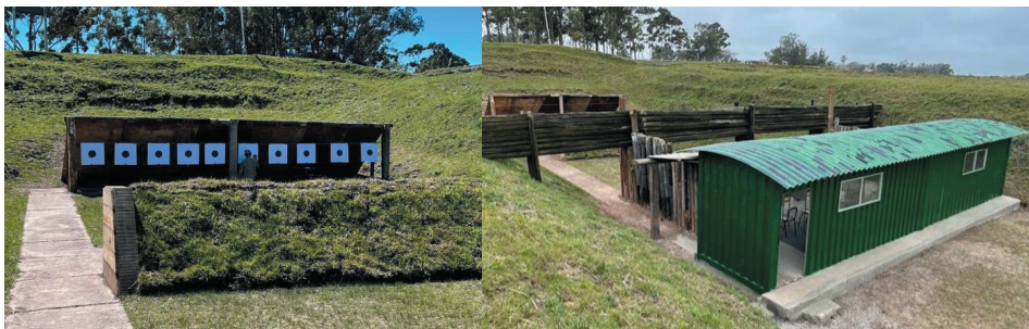
Imagen 5, 6, 7 y 8: Construcción de parabalas final e intermedio, reconstrucción de parábala aéreo y vista lateral de las instalaciones.
